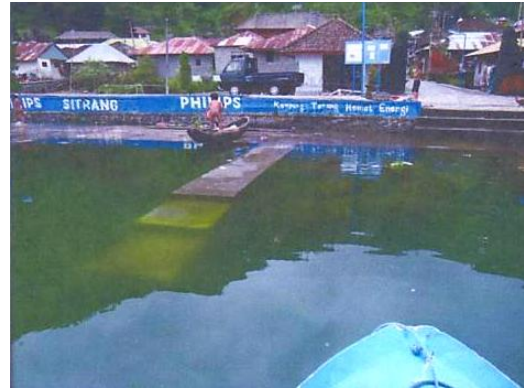
Gambar 5 Dermaga Beton di Desa Trunyan
