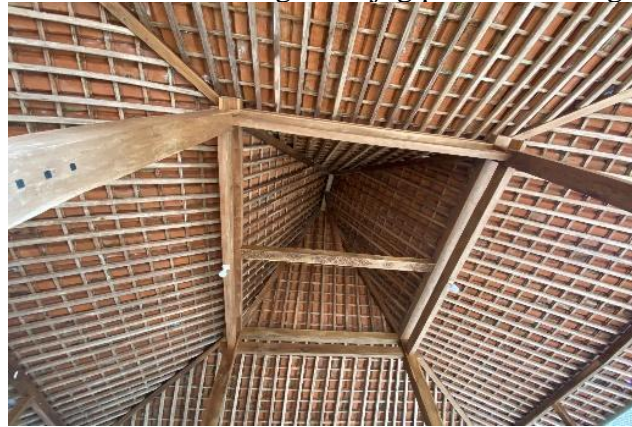
Gambar 3. Bentuk bagian Tajug pada rumah Joglo
