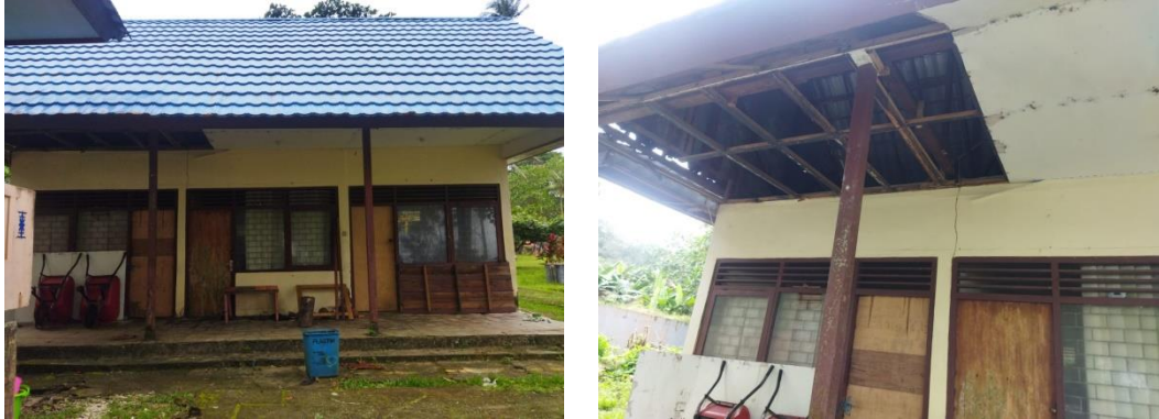
Gambar 3. Foto Gudang terletak disebelah kantor, perlu diperbaiki lagi plafon agar terlihat lebih rapi
