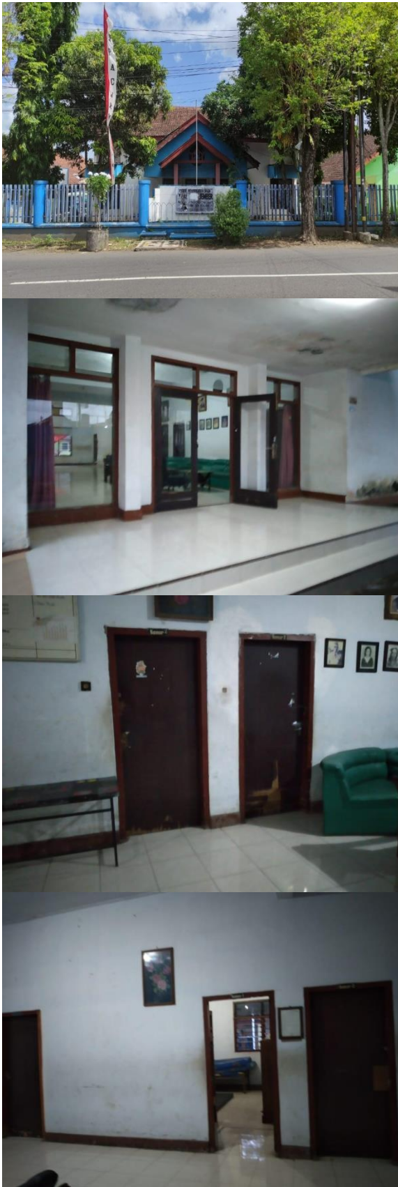
Gambar 1. Kondisi eksisting YAPC Kabupaten Jember
