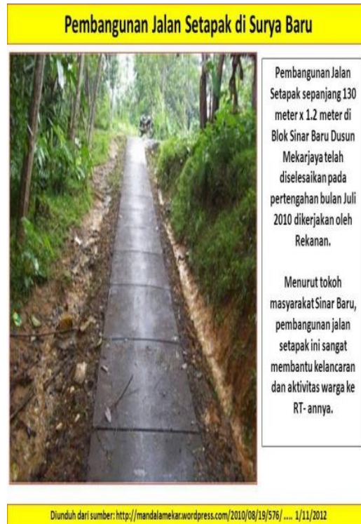
Gambar 11. Contoh bangunan jalan setapak yang dibuat dari beton menuju kebun
