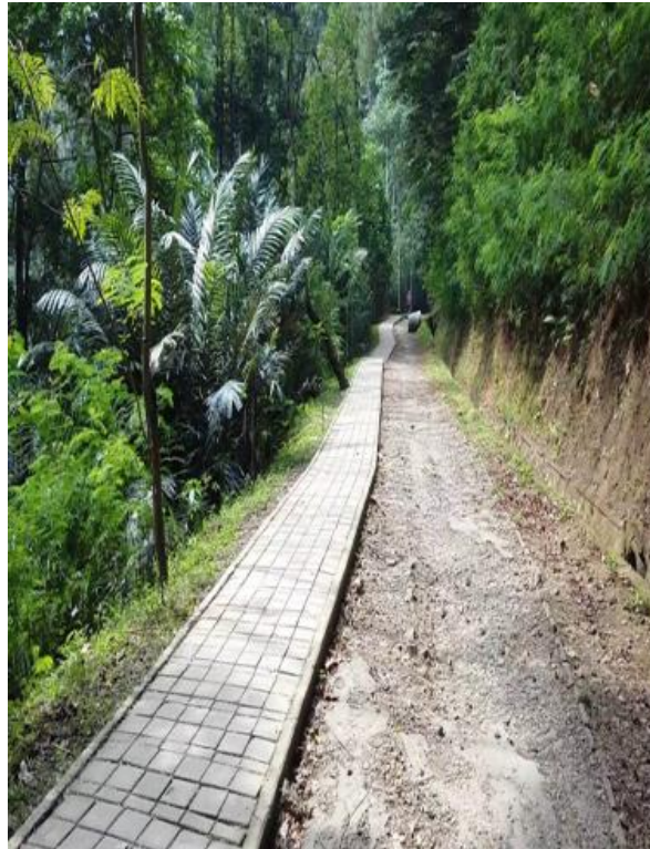
Gambar 13. Contoh bangunan paving jalan setapak menuju kebun
