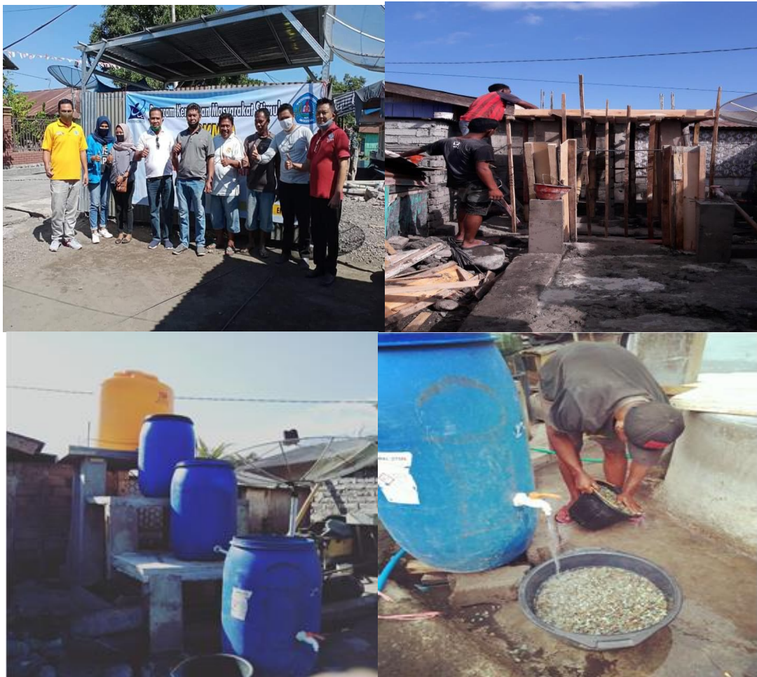
Gambar 1. Proses pembuatan alat penjernihan air metode filtrasi
