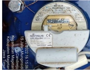
Gambar 3 dokumentasi Display Meter Induk tanggal 31/12/2022 jam 16:15:06 dengan totalizer 3.284.268 m 3
