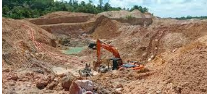
Gambar 1. Penggalian tanah menggunakan alat ekskavator
