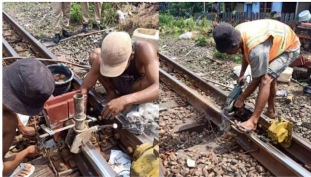
Gambar 1. Pengelasan dengan Las *Thermite* pada Proyek JGMS
