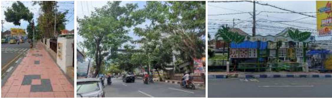
Gambar 3. Kondisi eksisting jalur pejalan kaki koridor Jalan Ahmad Yani
