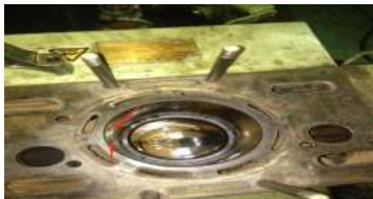
Gambar 10. Endapan Kerak pada Area Low Pressure Valve Plate
