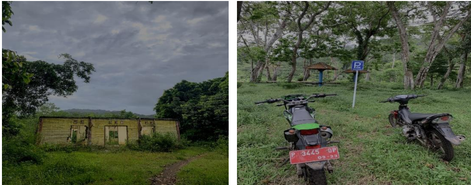
Gambar 6. Kerusakan fasilitas peribadatan dan tempat parkir Sumber: Survey Primer, 2021
