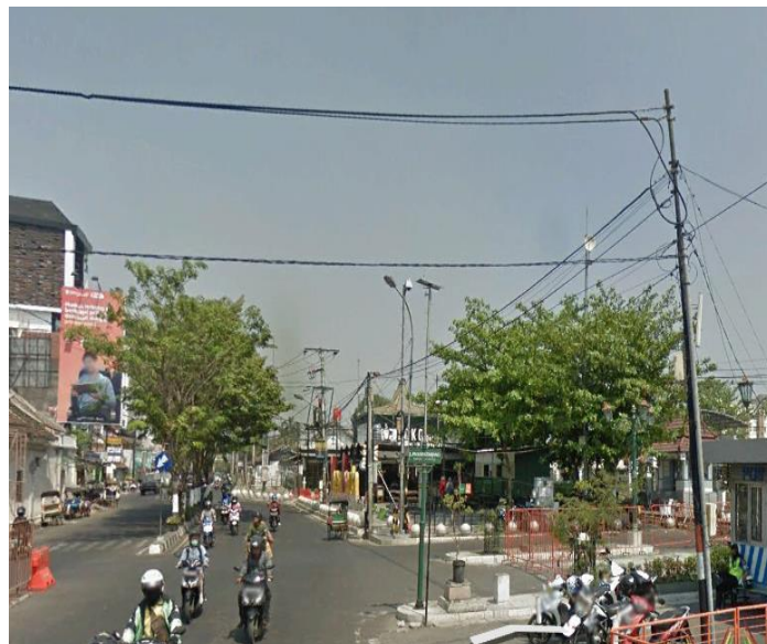
Gambar 4 Jaringan Listrik Sumber : Survey Sekunder, 2021
