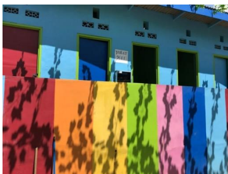
Gambar 3. Pembangunan WC Umum
