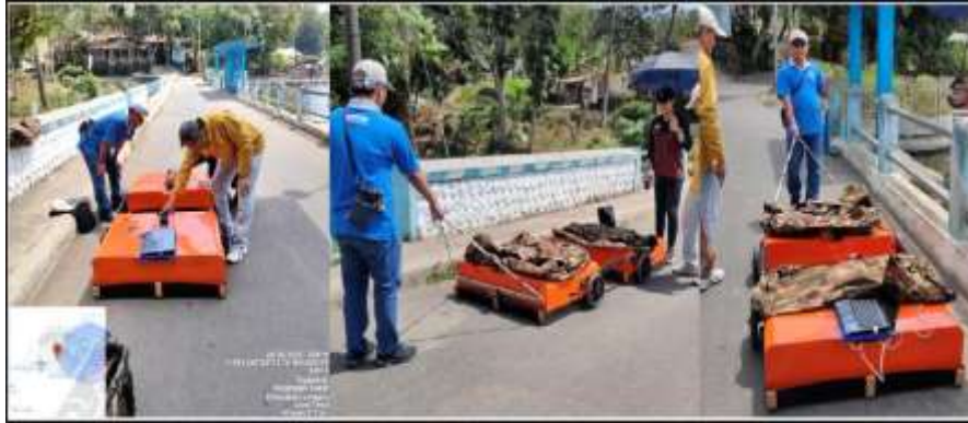
Gambar 11 Perakitan Alat GPR dan pengukuran Zona Rembesan Dam Ranu Klakah
