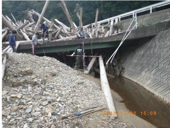
**Gambar 2** Penumpukan aliran debris kayu pada jembatan yang berada di Sungai Nayoshi (Tsuwano, 2013)
