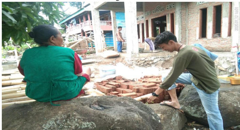
Gambar 1. Proses Pembangunan Rumah Perantau
