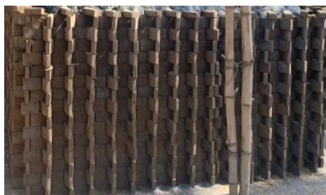
Gambar 10. Pagar Sekeliling Pembakaran
