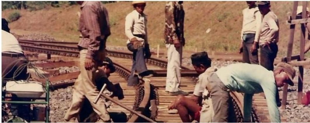
Gambar 3 Proses Pemasangan dan pembengkokan rel Tahun 1983
