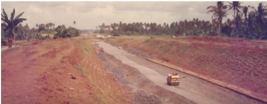
Gambar 2. Proses Pemerataan Tanah Jalur Kabat-Meneng Tahun 1983
