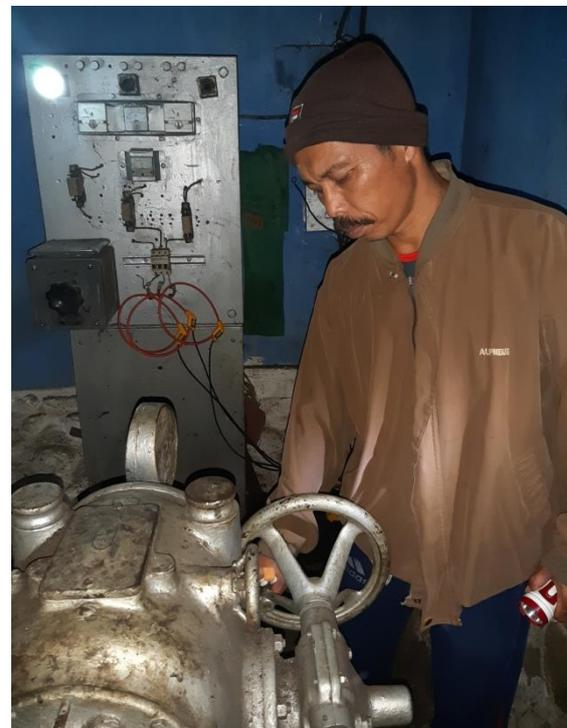
**Gambar 5.** Pengaturan *guide fane* suplai air turbin PLTMH Gunung Pasang oleh operator
