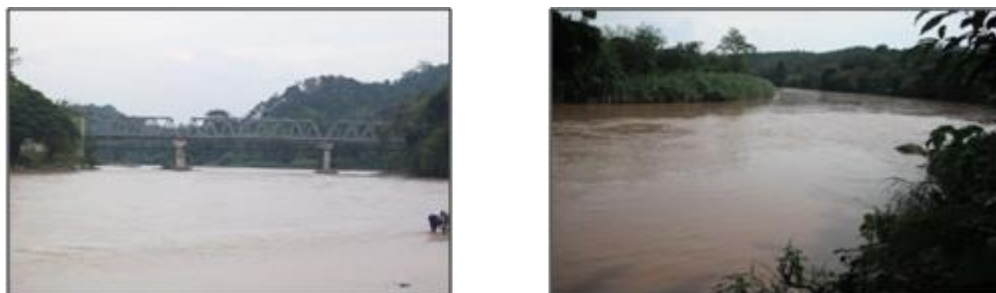
Gambar 5. Kondisi jaringan di kawasan hulu sungai Sub DAS Komerling Hulu
