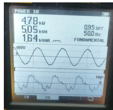
Gbr. 15 Nilai pengukuran 3 daya dan faktor daya dengan adanya Detuned Reactor 7% + kapasitor. Dengan nilai daya reaktif perbaikan Q_c adalah :
