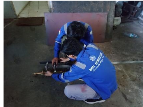
Gambar 1. Proses instalasi alat
